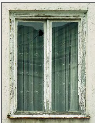
Vor der Erneuerung
