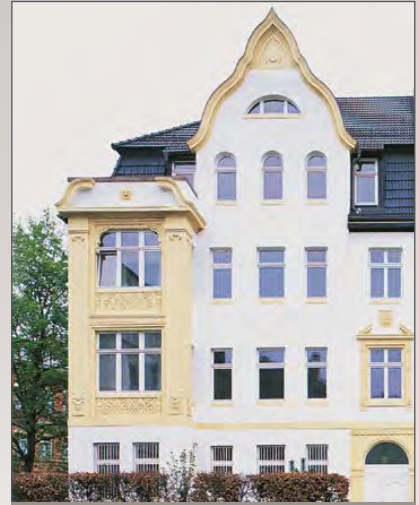
Nach der Erneuerung
