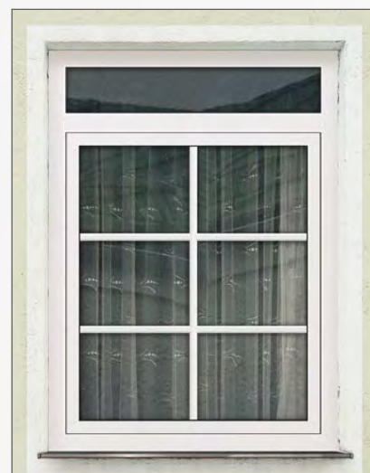
Nach der Erneuerung
