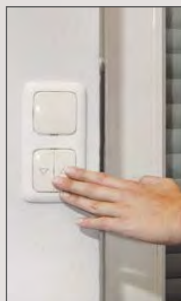
Motorantrieb (Steuerung per Taster oder Fernbedienung)
